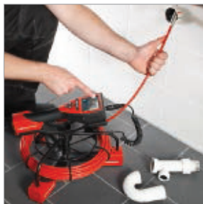
Pregled odtoka pomivalnega korita
