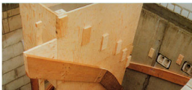
Danach wird das "Innenaugen" eingebaut und befestigt
