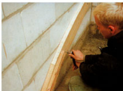
Holme oder Wangen mit Dübel 80 x 8 mm an der Wand befestigen
