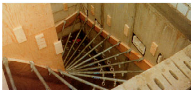
Die Teleskopstäbe werden im Abstand von ca. 30 cm an den Wangen mit Pappstiften von 35 mm befestigt
