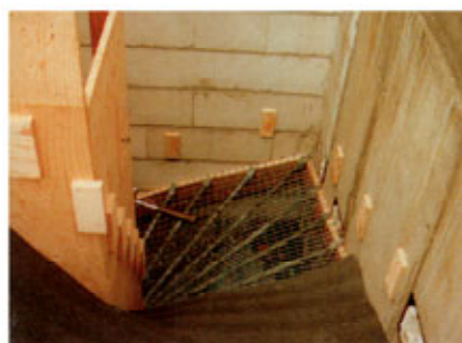
Der Treppenbelag wird auf das Wellengitter aufgelegt und passend abgeschnitten. Die Befestigung erfolgt mit Rödeldraht an den Teleskopstreben.
