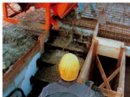
Anschließend wird Beton B25 - 0-16 Körnung mit einem Ausbreitmaß von 35 - 40 cm in die Treppenstufen gegossen.
