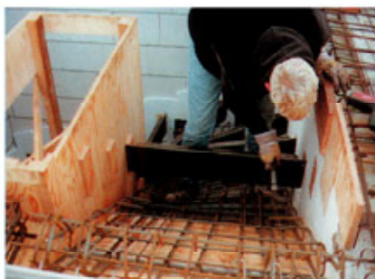
Die ausziehbaren verzinkten Treppenstufen werden mit 65er Nägel an den Stufenlaschen befestigt.
