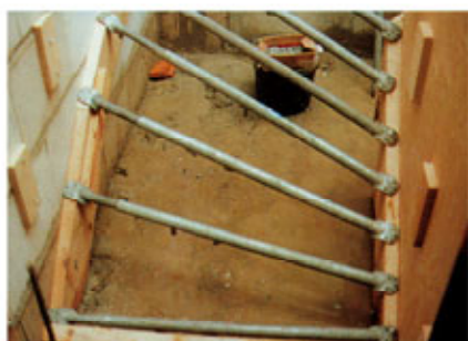
Die Montage der Teleskoprohre erfolgt von unten nach oben.
