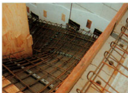
Die Bewehrung bzw. Eisen wird mit entsprechenden Abstandhalter verlegt und befestigt. (42 Laufmeter Rundeseisen 8 mm und ca 8 m 2 Bewehrung Q 131)
