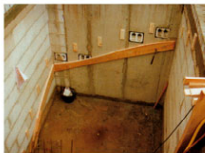
Holme oder Wangen mit Dübel 80 x 8 mm an der Wand befestigen
